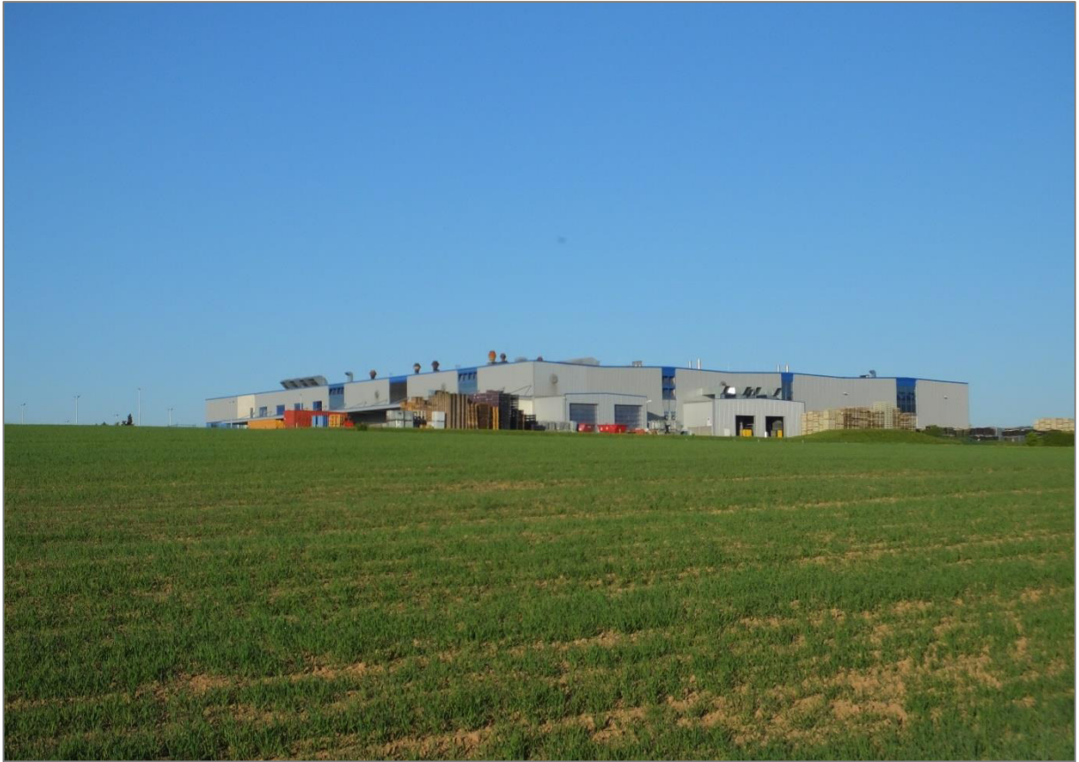
Abbildung 6: Blick von Nordost auf das Plangebiet und das bestehende Betriebsgelände der Firma Borbet.
