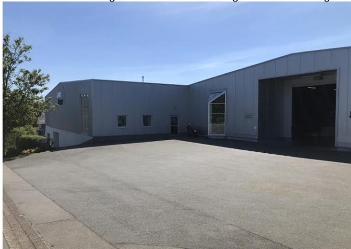
Abb. xx – Blick auf die Halle 1 (im Hintergrund) und die Halle 2 [ Beuke 11] (mit offenen Tor zum Be- und Entladen), Straße ‚Beuke‘ mit 2-lagigem Betonsteinpflaster als Regenablaufrinne mit versenkten Schrammbord und übergangslos asphaltiert die Park-, Lager-, Be- und Entladefläche der Firma ‚Jäger & Frese‘
