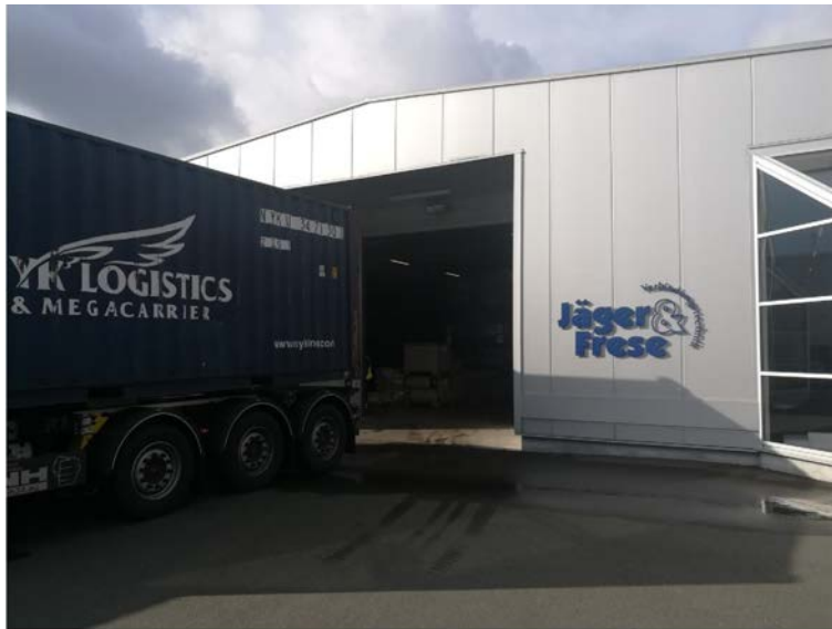
Abb 66 - Blick in die Lagerhalle 2
