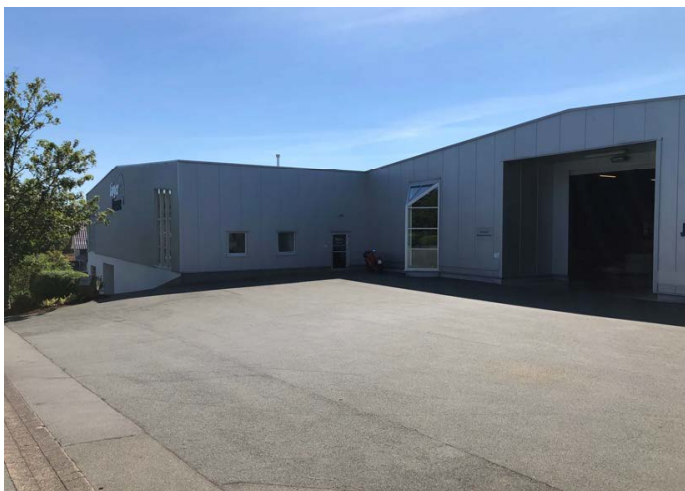
Abb. 54 – Blick auf die Halle 1 (im Hintergrund) und die Halle 2 [ Beuke 11] (mit offenen Tor zum Be- und Entladen), Straße ‚Beuke‘ mit 2-lagigem Betonsteinpflaster als Regenablaufrinne mit versenkten Schrammbord und übergangslos asphaltiert die Park-, Lager-, Be- und Entladefläche der Firma ‚Jäger & Frese‘
