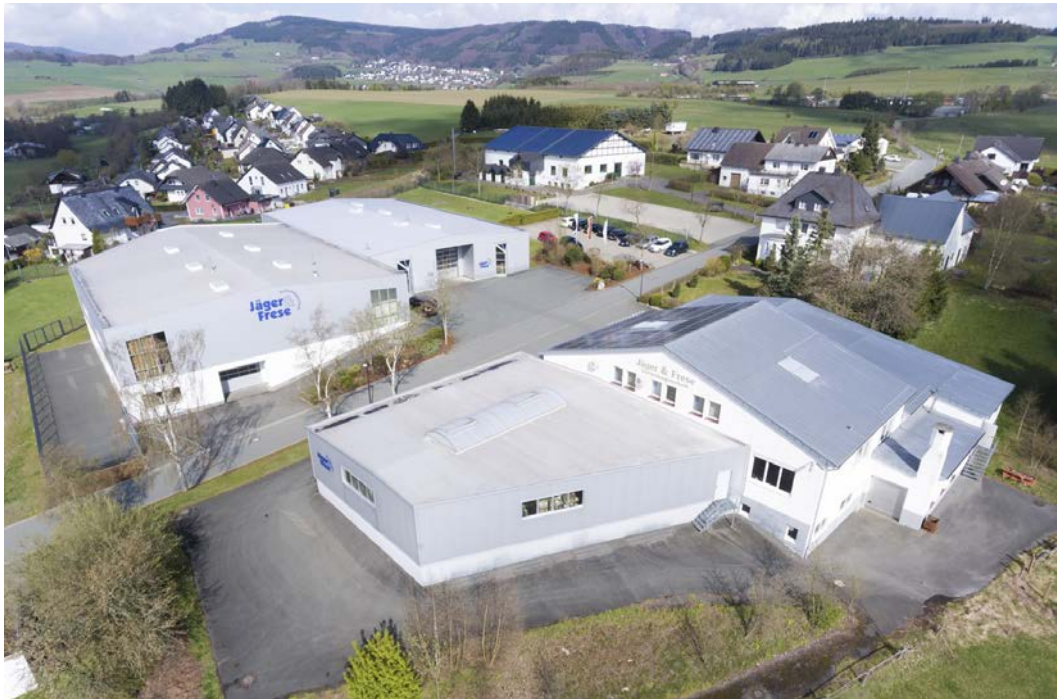
Abb. 2 – Luftbild des Betriebes Jäger & Frese mit Schützenhalle, Baugebiet ‚Zur Mülheide‘ (2018) und die nördlich angrenzende Wohnbebauung, zugelassen gemäß § 6 Abs. 2 Nr. 1 BauNVO
