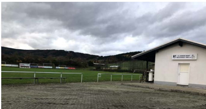
Abb. 51 – Fußballplatz mit Umkleidegebäude des ‚SV ‚Schwarz-Weoß‘ Oberschledorn 1028 e.V.‘
