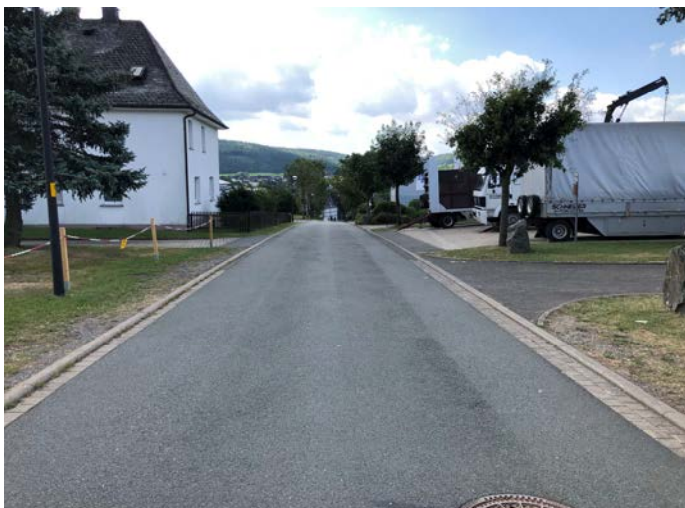
Abb. 57 und 58 – Erschließungsstraße ‚Beuke‘ mit privat angelegten/angedeuteten begleitenden Fußwegen/Rasenflächen - Blick vom Norden in Richtung Süden
