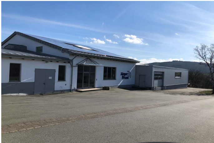
Abb. 55 - Blick auf das Verwaltungsgebäude mit den beidseitigen Werkstattgebäuden [Beuke 10], Straße ‚Beuke‘ mit 3-lagigem Betonsteinpflaster als Regenablauftrinne ohne Schrammbord und übergangslos asphaltiert die vorgelagerten Parkplätze, Tore mit Lager-, Be- und Entladefläche sowie zum Transport in die Halle 2 der Firma ‚Jäger & Frese‘
